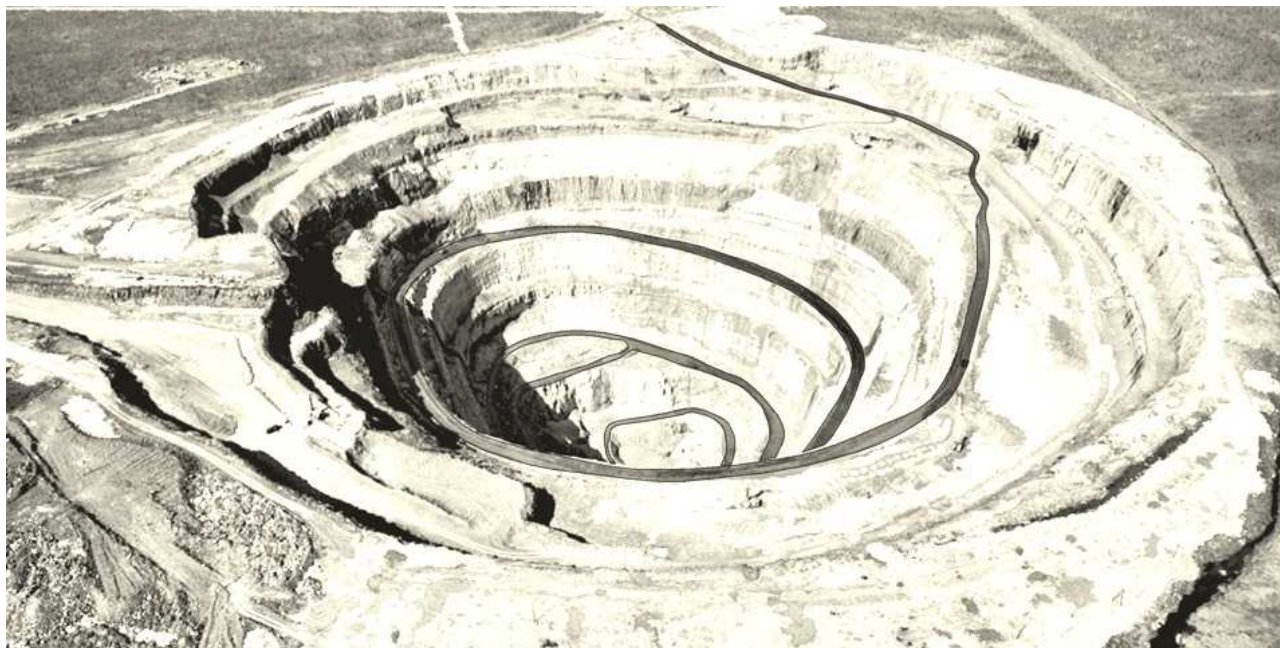
Рис. 2.20. Фото кар'єра, розкритого спіральними траншеями
